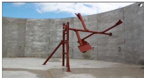
Figure 13 : agitateur à pales du digesteur
