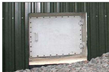
Figure 32 : photo type d'une trappe d'entrée dans la cuve
