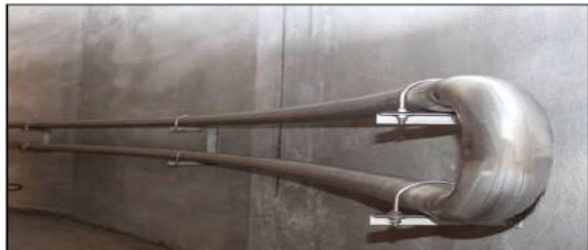
Figure 14 : boucle de chauffage interne aux digesteurs
